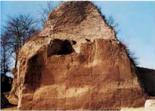
古城寨夯土城牆斷面，最高處距地表 16 米多
