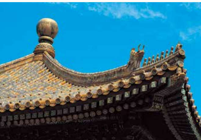
宮殿建築彎曲的屋頂
