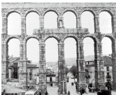
圖 1-3 古羅馬輸水道拱券結構
