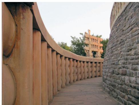
1:1:7 大塔與欄楯之間 東門背面
