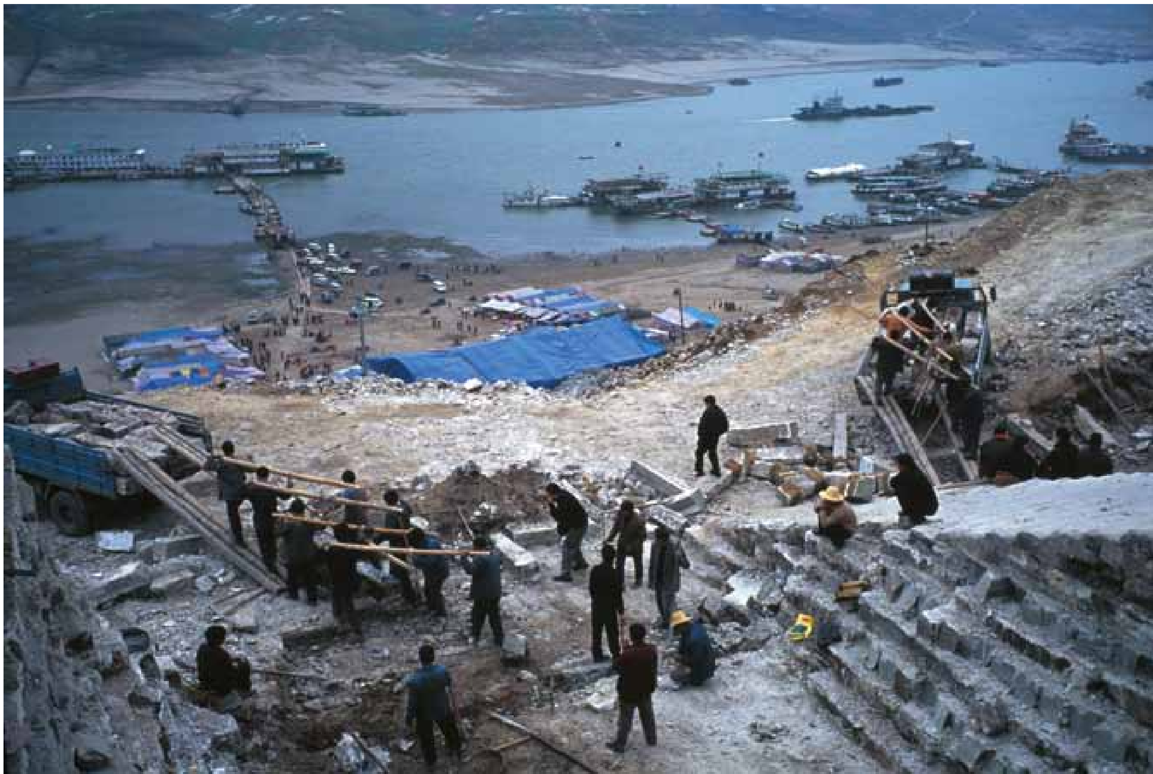
正在拆遷準備在新奉節寶塔坪重建的 依斗門。 2003 年 2 月
