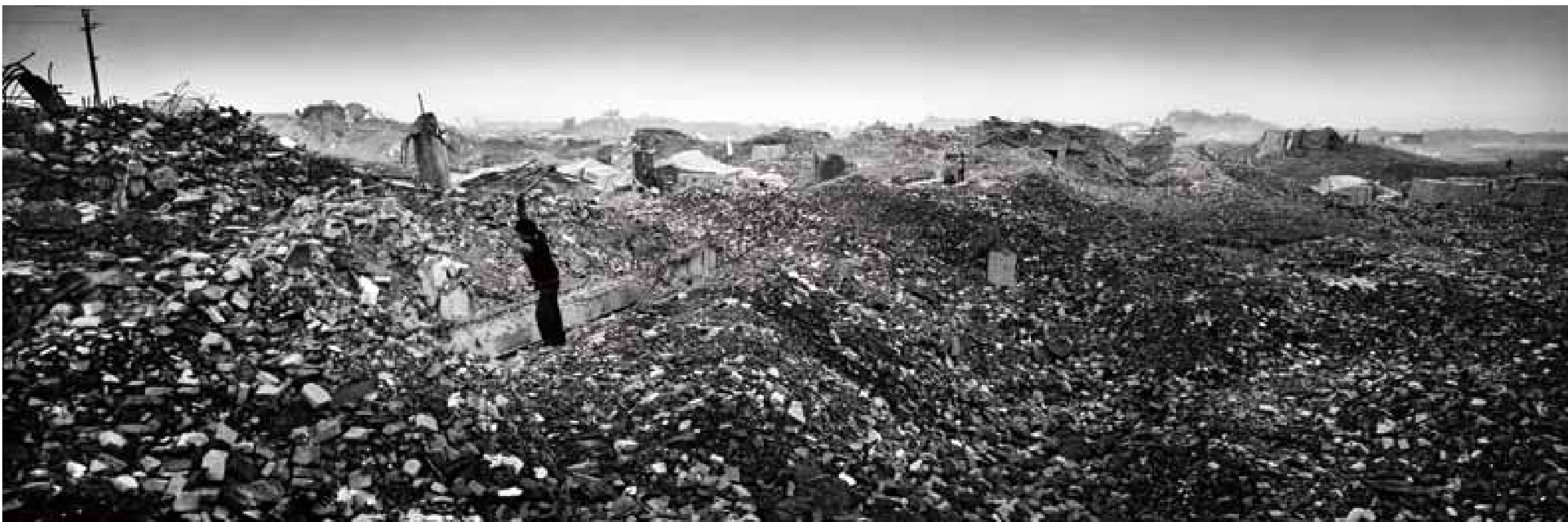
為迎接三峽蓄水，奉節古城正在拆遷。
